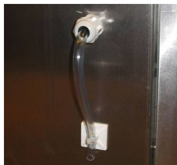
Figur 5. Montering av tryckslang för mätning av atmosfärstrycket.
