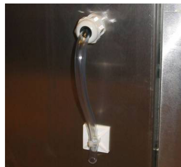
Figur 2. Montering av tryckslang för mätning av atmosfärstrycket.
