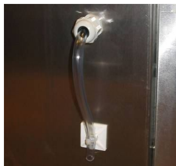
Figur 5. Montering av tryckslang för mätning av atmosfärstrycket.
